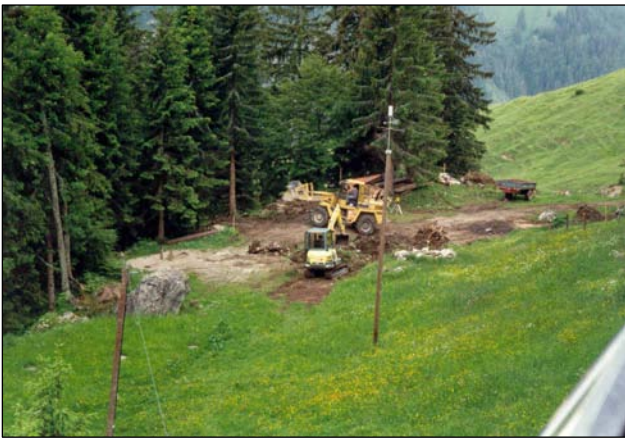
Der Bauplatz wird vorbereitet
