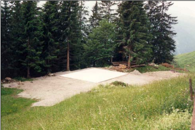
Das Fundament fest gemauert in der Erde
