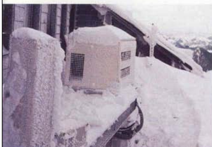
▲ Extreme Bedingungen im ersten Winter für die STIEBEL-ELTRON-Wärmepumpe
