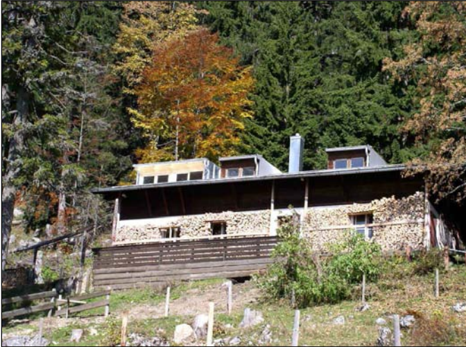
Im Dachgeschoß der Brunnsteingarage / Werkstatt wurde im Jahre 2002 ein Selbstversorgerraum für die Jugend der Sektion und Familien mit Kinder errichtet. Eine Dachgaube gibt den Blick nach Süden frei
