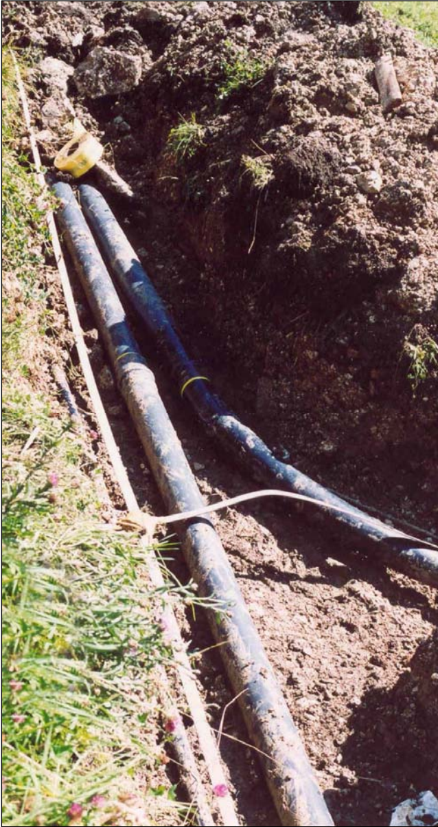
Hier soll die Station Brünstein stehen.
