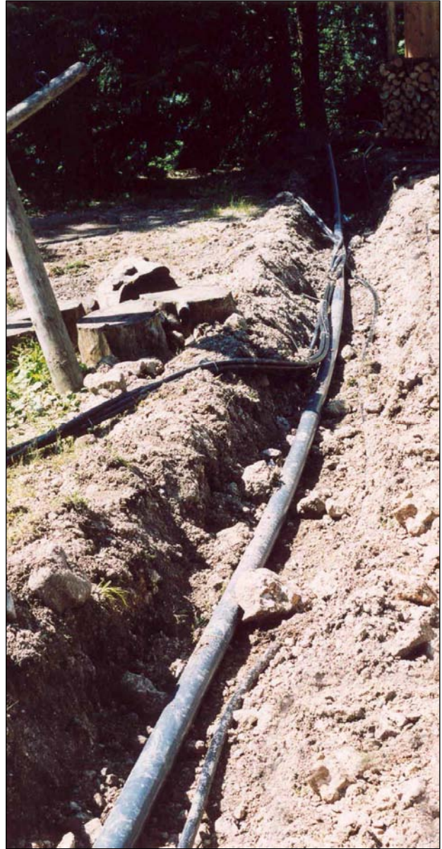
Anschlüsse für Station, Haus und späterer Abwasserpumpstation.
