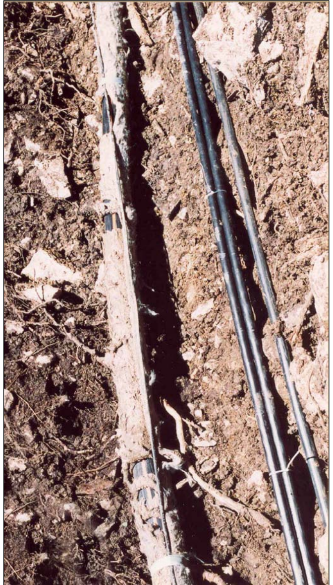
Vliesbeschädigungen
