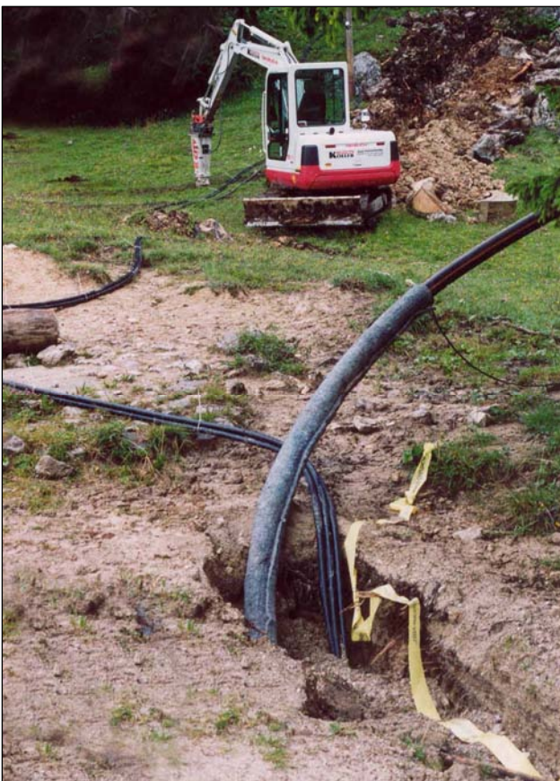
Anfang des Fräsgrabens.
