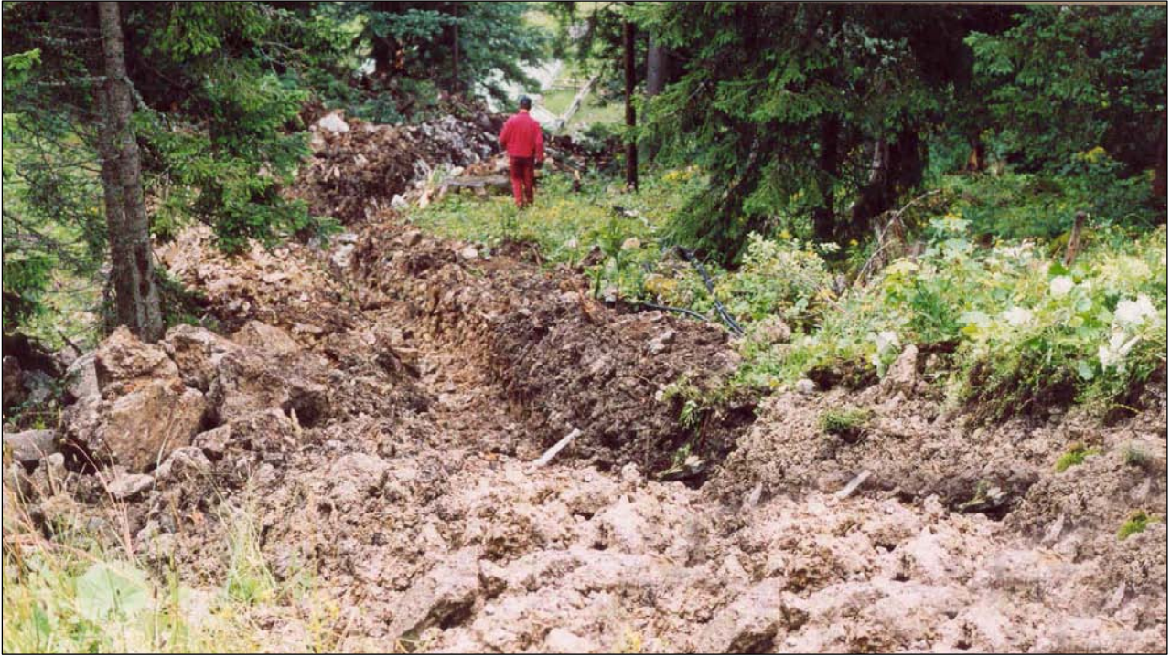
Schwieriges, stein- und wurzelreiches Gelände
