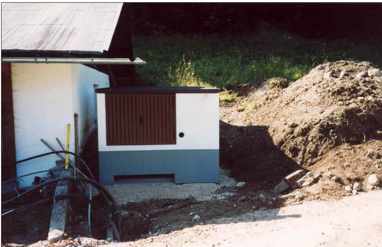
Die neue 20 kV-Kabelstation Rechenau. Eigentum der Gemeinde Kiefernfelden. Anschlussstelle des DAV-Kabels zum Brunnsteinhaus.
