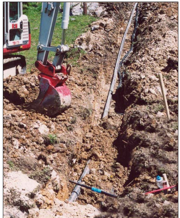
Die Wasserleitung mußte Vorübergehend durchschnitten werden.
