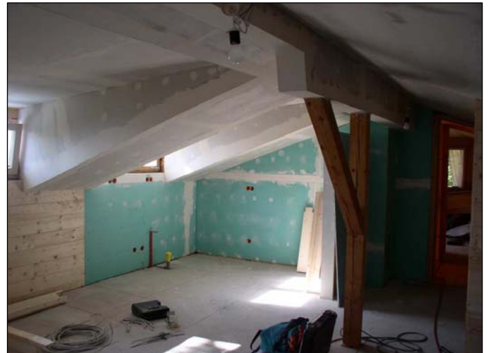
Der Innenausbau mit Rigips an den Wänden und Hamberger Parkett am Boden
