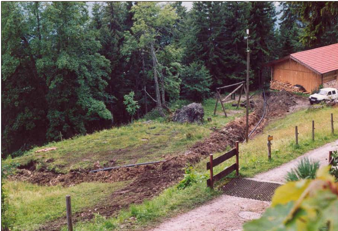
Graben sauber geschlossen. Abflussrohr der Kläranlage.
