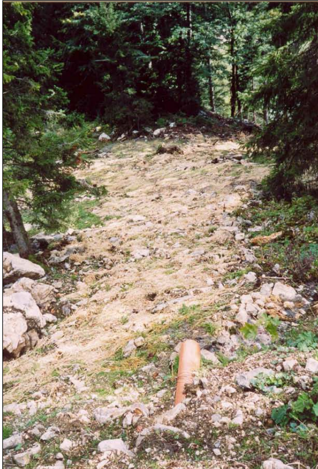
Graben sauber geschlossen. Abflussrohr der Kläranlage.
