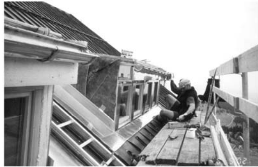
Arbeiten am Dach
