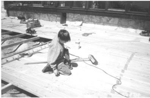
Der Bau der Terrasse nimmt Gestalt an
