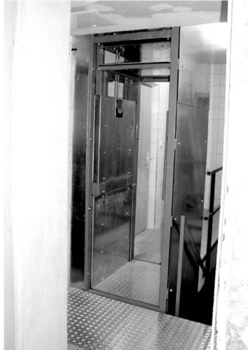
Lastenaufzug in den Keller
