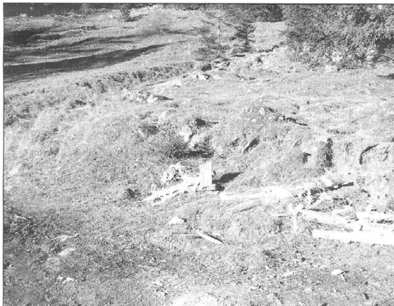
Wasserleitern und Sperrzäune wurden im Hochriesgebiet einfach eingerissen. Erst im August waren sie unter hohem finanziellen Aufwand errichtet worden, um die Erosion in diesem Gebiet aufzuhalten.
