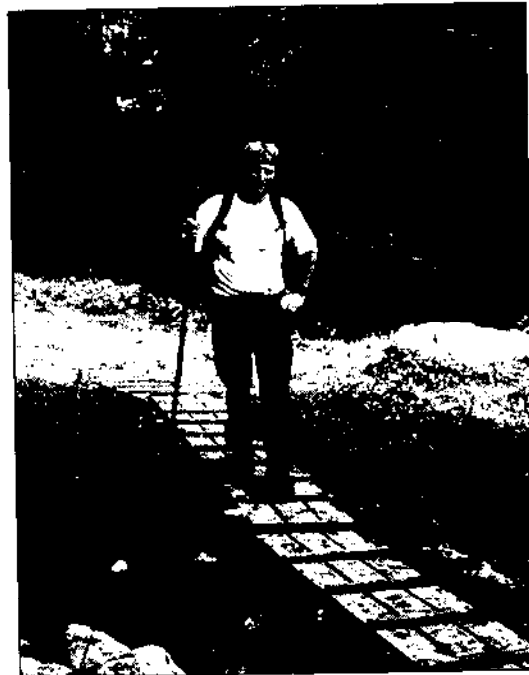
Der fertige Bohlenweg kurz vor der Seeonalm
