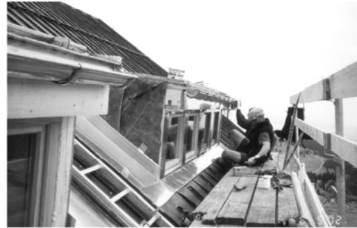
Arbeiten am Dach
