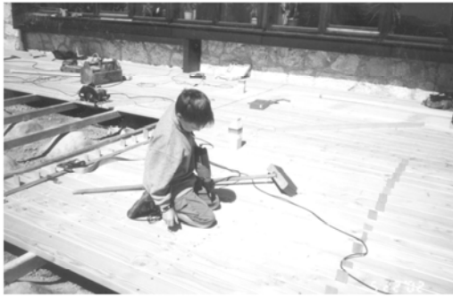
Der Bau der Terrasse nimmt Gestalt an
