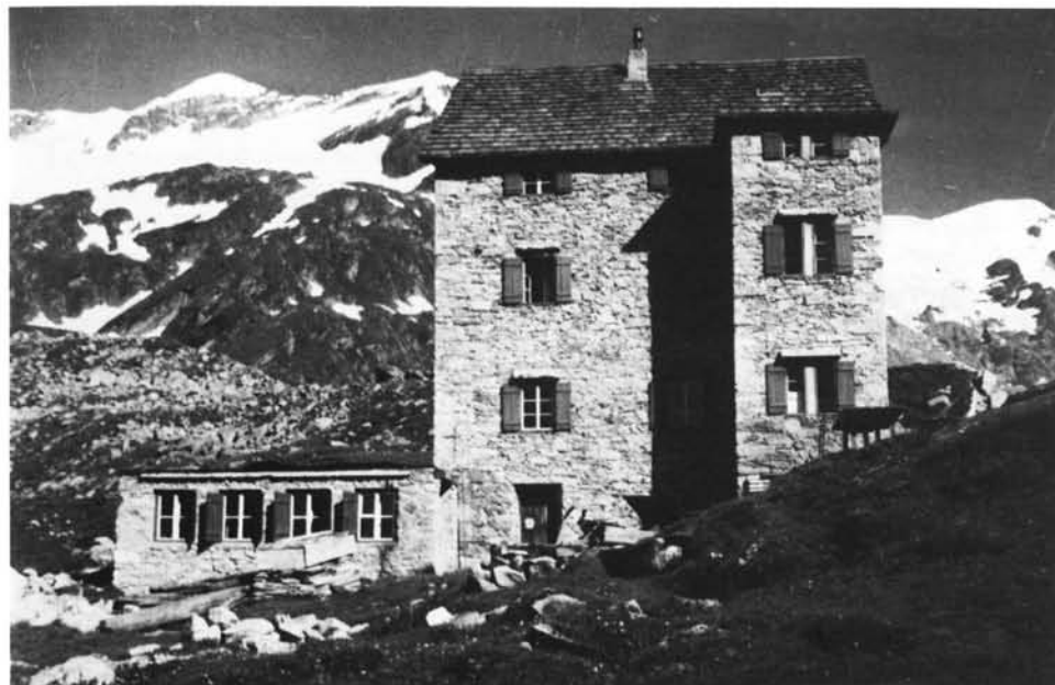
Rostocker Hütte beim Anbau des Winterraumes
