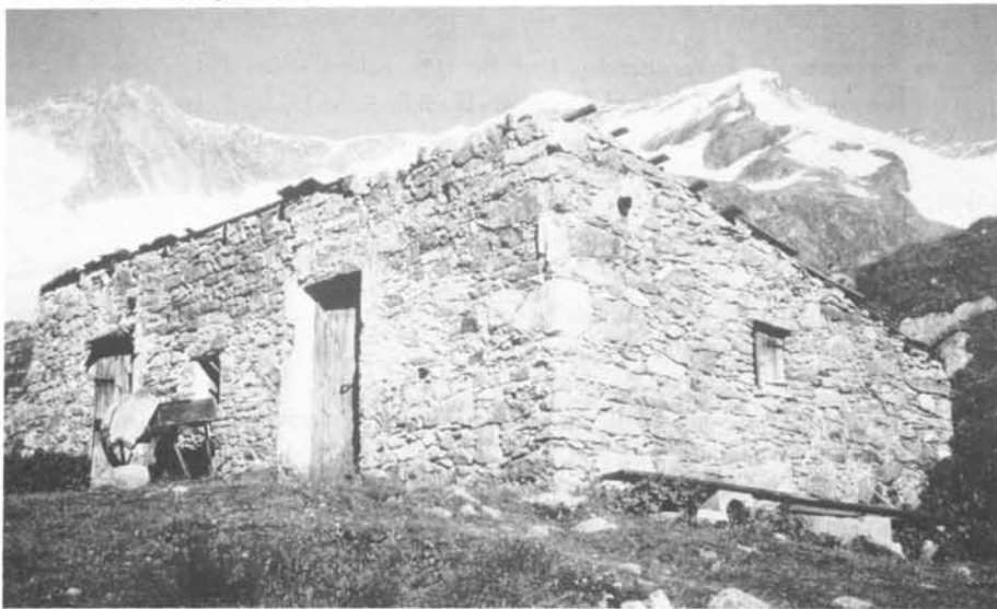
Winterbau 1980 - noch mit zwei Eingängen für „Männlein und Weiblein“ - zuletzt nur noch als Stall genutzt
