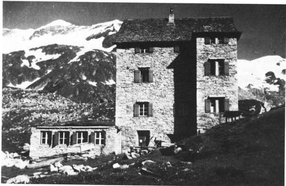
Rostocker Hütte beim Anbau des Winterraumes
