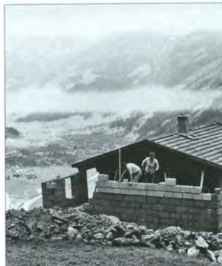
Die drei Bilder zeigen die aufwändigen Umbauarbeiten in den Jahren 1977 und 1978
