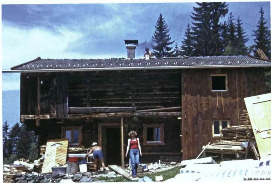
1978: Die umfangreichen Umbauarbeiten nähern sich langsam aber sicher dem Ende
