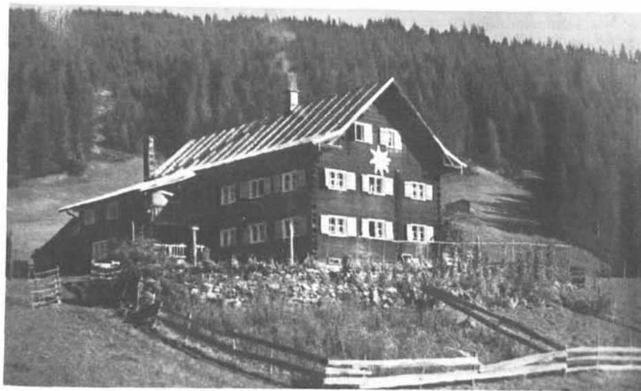
Mahdtalhaus vor dem Umbau
