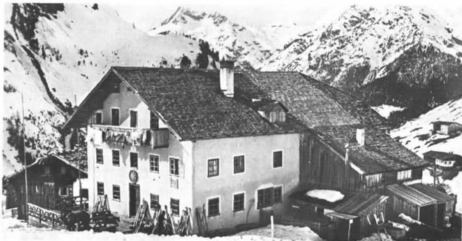
Das Edelweißhaus vor dem Umbau in den Jahren 1957/58
