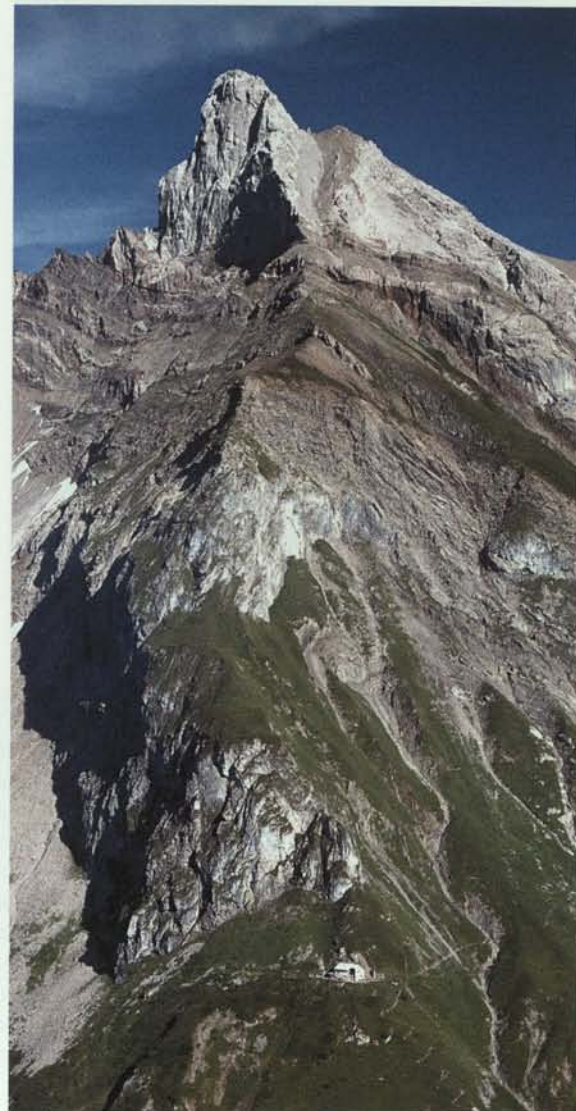
Blick auf die Frederic-Simms-Hütte, überragt von der Holzgauer Wetterspitze.
