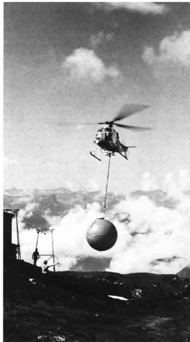
Die Behälter der Kläranlage im Anflug
