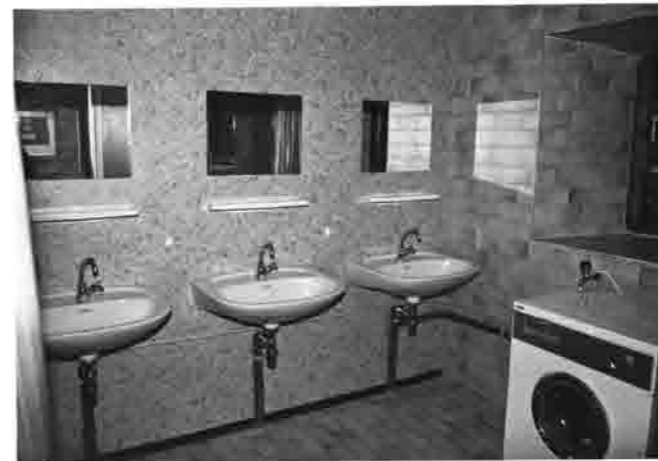
Der neue Waschraum
