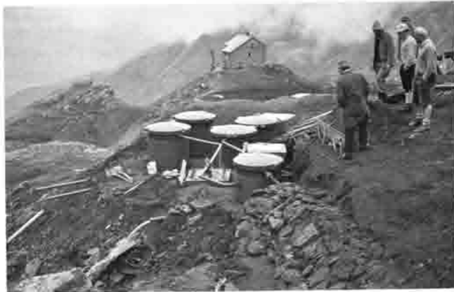
Die Wasserversorgung im Bau (Speicher)
