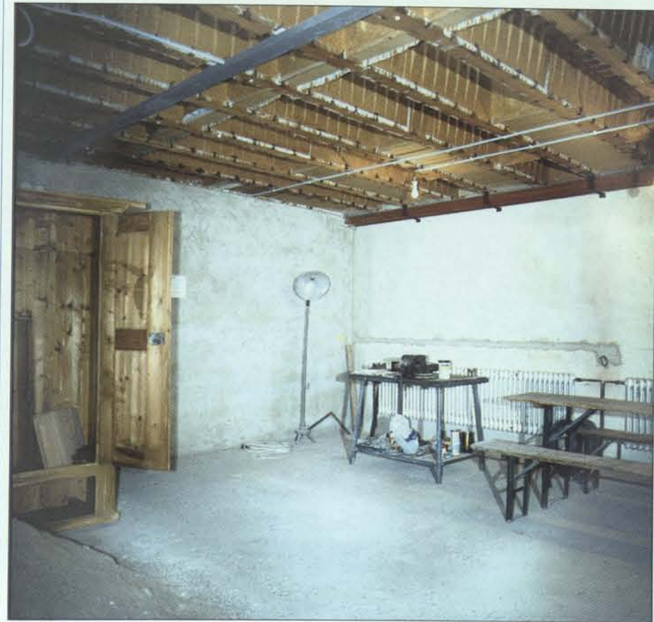
Unser AV-Heim 1984 als Roh-Baustelle...
