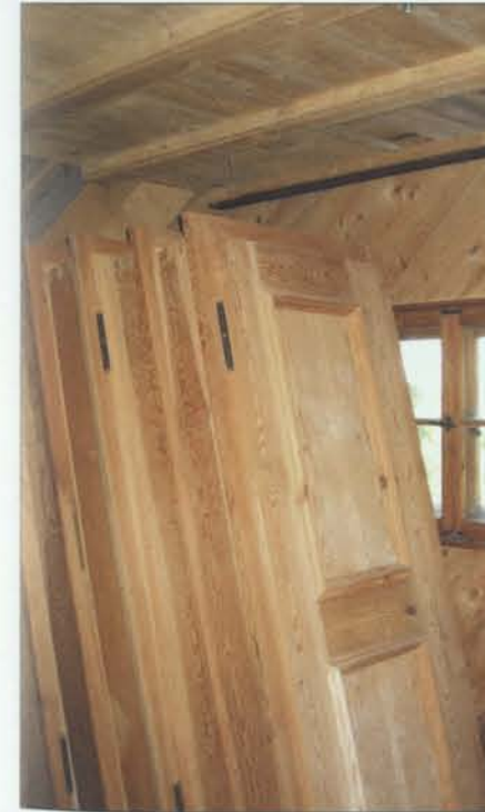
...die Türen wurden bald eingebaut...
