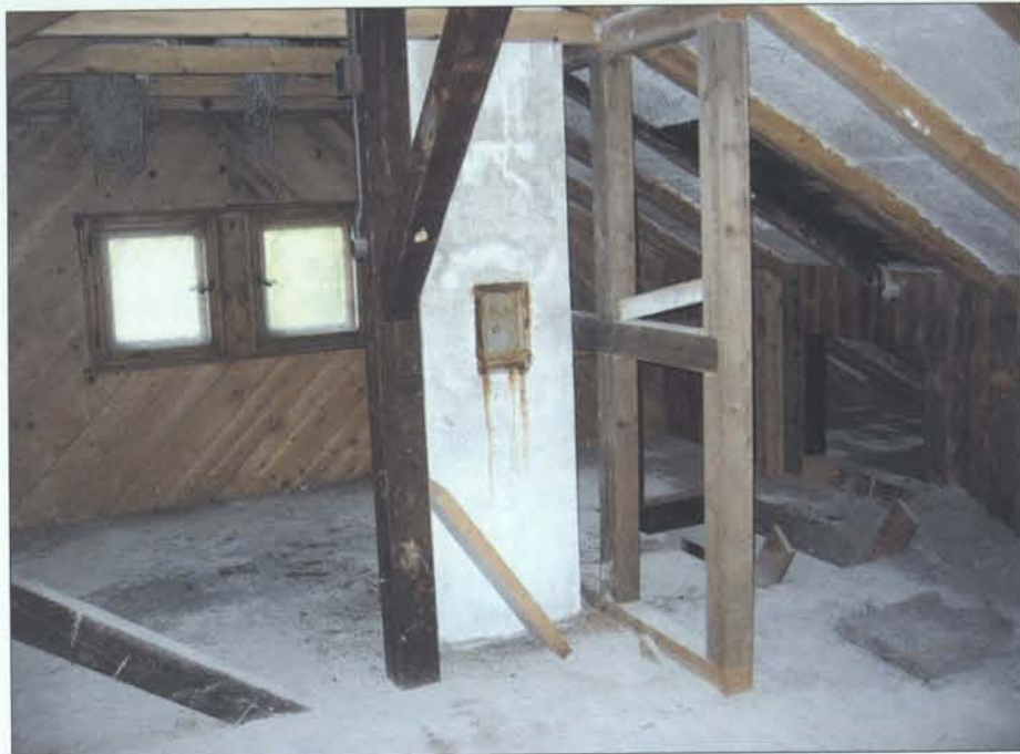
Das Dachgeschoß zuvor im ursprünglichen Zustand...
