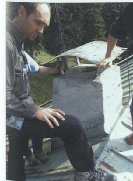
Auch der zuständige Kaminkehrer wurde im Vorfeld zu Rate gezogen...
