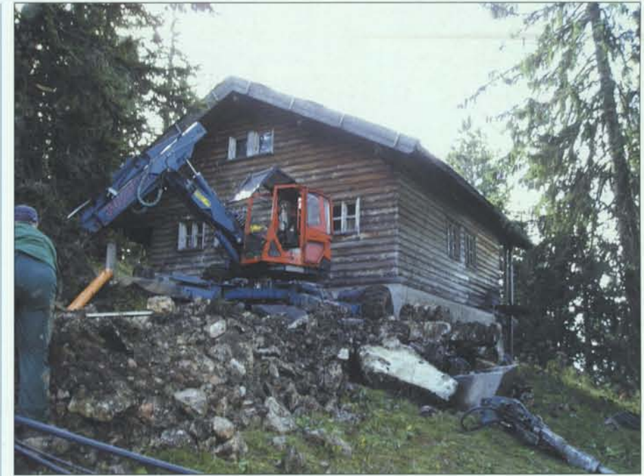
Als erstes war dann schweres Gerät im Einsatz...
