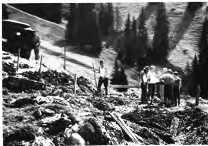
Erdaushub am Standpunkt der neuen Hütte
