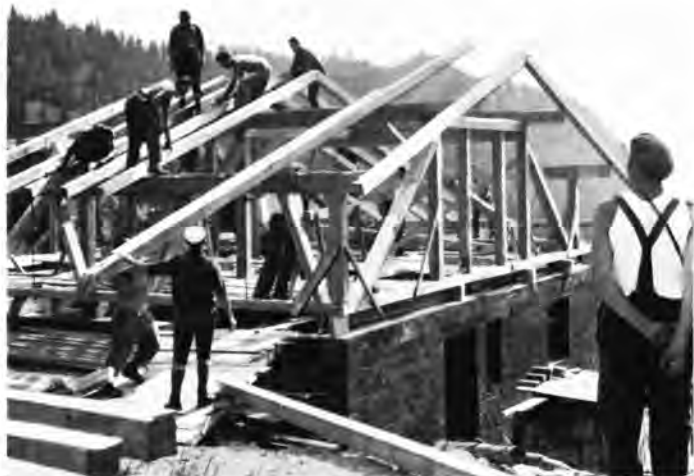
Aufbau des Dachstuhls
