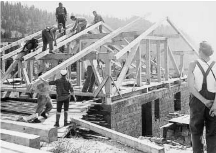
Aufbau des Dachstuhl.
