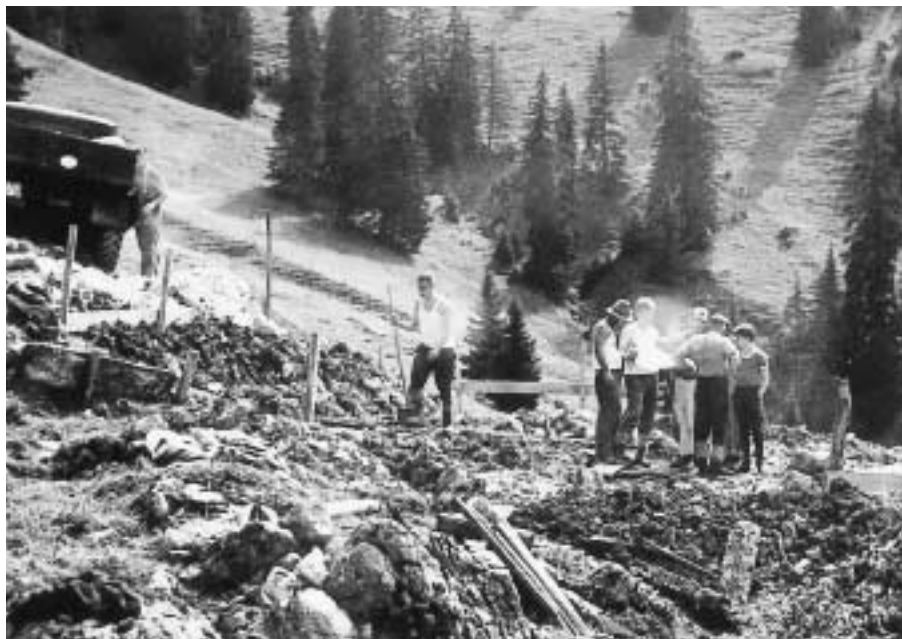
Erdaushub am Standpunkt der neuen Hütte.
