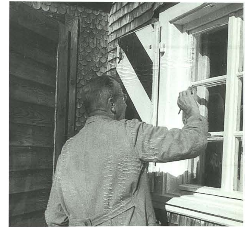
Karl Weiger beim Streichen der Fenster.
