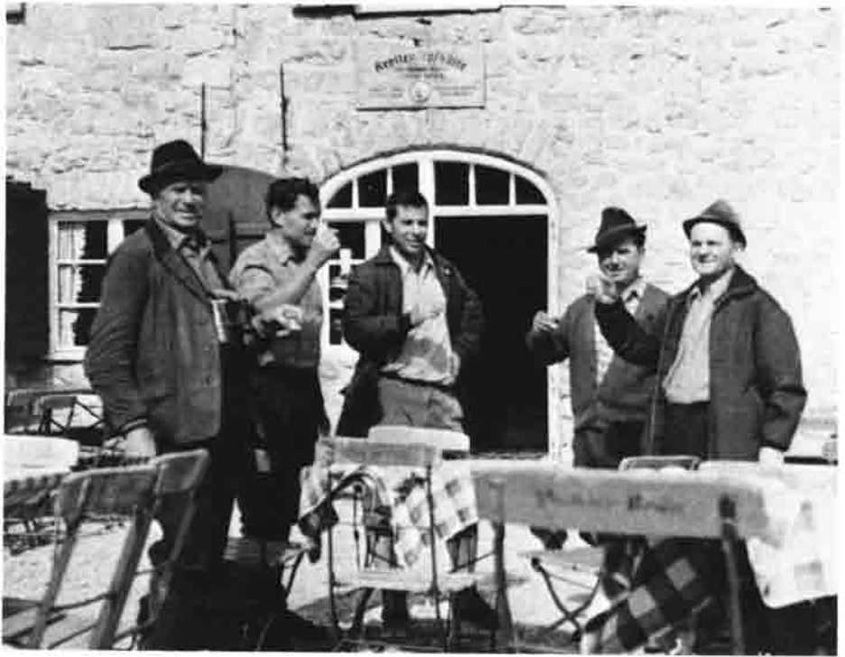
Kommission für den Bau der Transportbahn 1968
