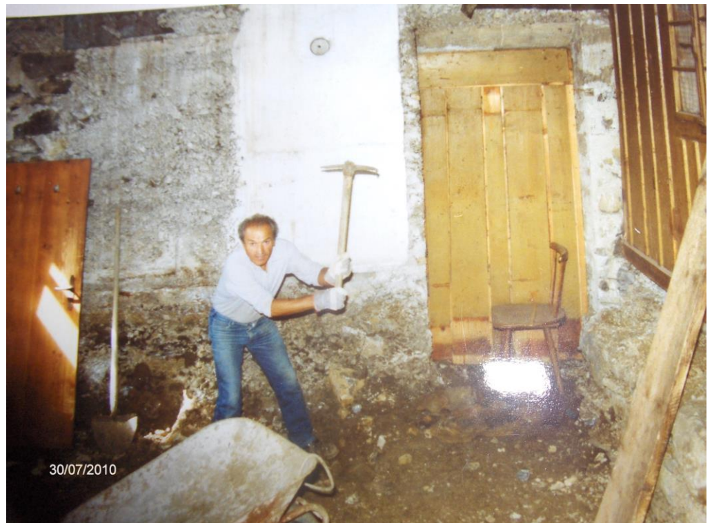
Ausgrabungsarbeiten im entkernten Farchanter Anbau in Eigenleistung
