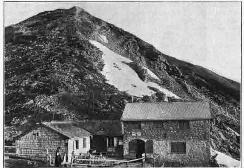
Krottenkopfhütte nach dem Ausbau 1910
