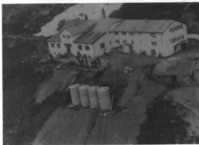
Wiesbadener Hütte — Bau der Kläranlage 1981
