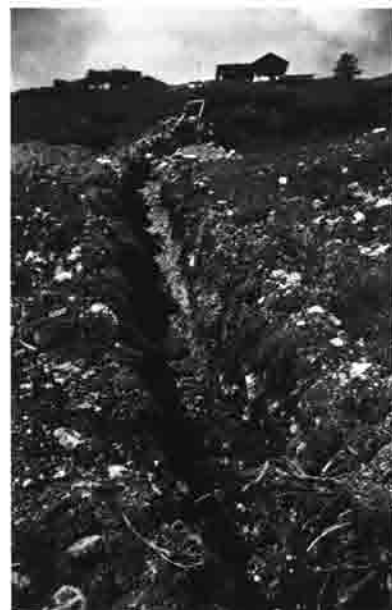
Der Gebirgsbagger „Menzie-Muc“ gräbt den über 600 m langen Wasserleitungsgraben.
