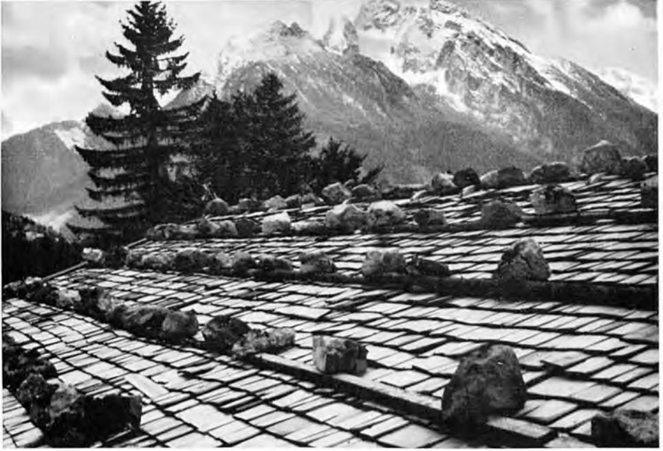
*Bild 26: Legschindeldach*
