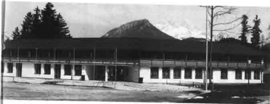
Schulhaus in Schönau am Königssee – Schneewinkl: 1983/84 erbaut, harmonisch in die Landschaft eingefügt. – Die modernste Schule –
