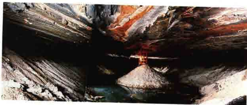
Initialhohraum für ein Bohrspülwerk
