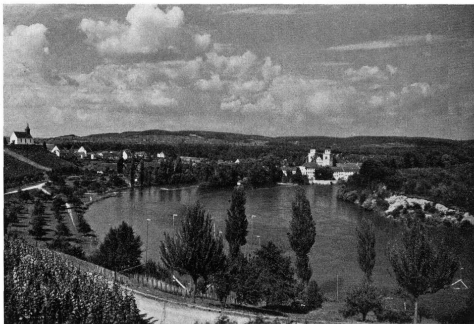
Aufn. Osk. Grob, Bülach-Zürich Ehemaliges Inselkloster Rheinau, Kanton Zürich. Im Vordergrund ist die Absteckung des Maschinenhauses des im Bau befindlichen Kraftwerkes sichtbar.
