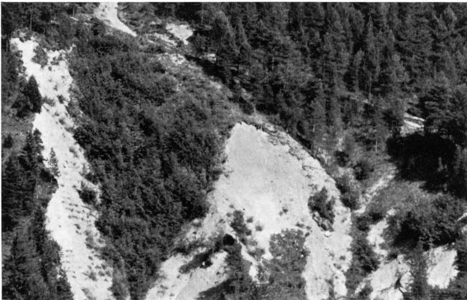
Abb. 6 und 7 Stichriepe bei Hochzirl im Oberinntal, 1000 m ü. d. M. Oberes Bild bei Beginn der Arbeiten 1950. Darunter der Zustand 1960. Für Versuchszwecke wurde nur eine Teilfläche begrünt. Im rechten Runst begnügte man sich mit einer Sicherung der Sohle gegen weitere Eintiefung
