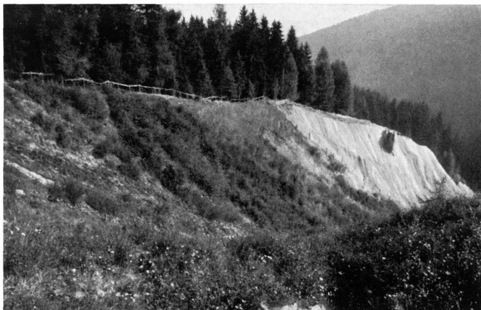
Abb. 4 und 5 Teilstück der großen Blaike im Geroldsbach bei Götzens, ca. 10 km südwestlich von Innsbruck, 1500 m Seehöhe. Oben zu Beginn der Abböschungsarbeiten 1951, unten im Jahre 1959; vorne begrünter Teil, im Hintergrund die unveränderte, nicht begrünzte Teilfläche
