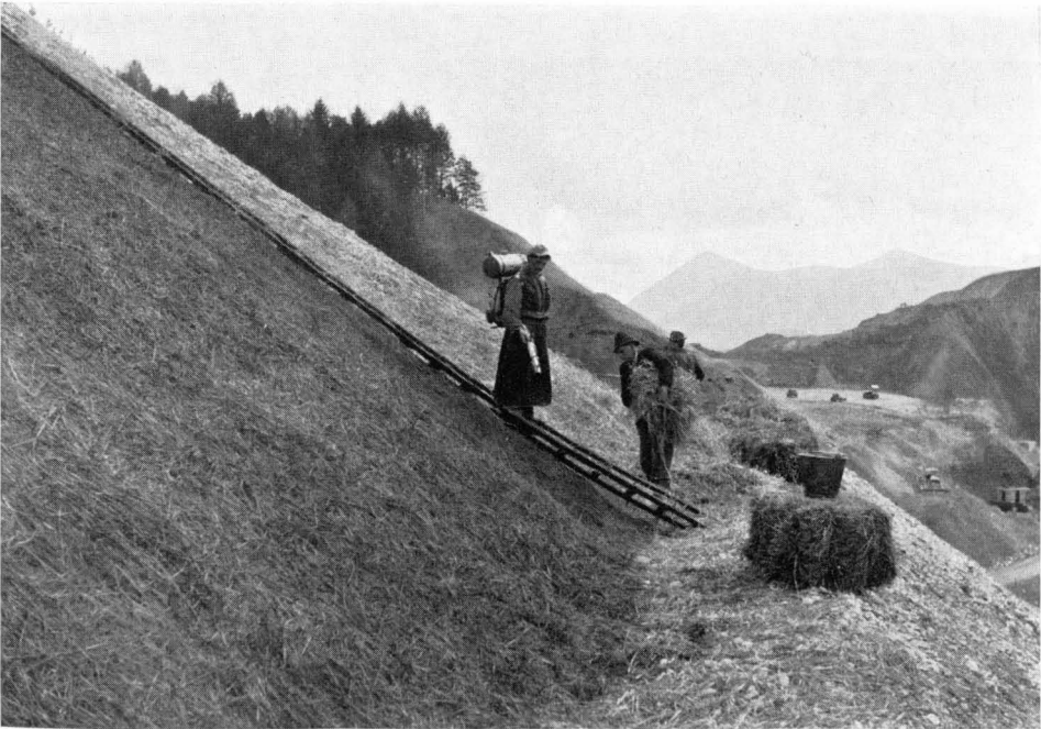
Abb. 3 Begrünung des 150 m hohen Ahrnbergeinschnittes an der Brenner-Autobahn mit Hilfe der „Saat auf Strobedeckschicht“. Die hier in Arbeit befindliche Böschung wurde bereits zwei Monate später gemäht
