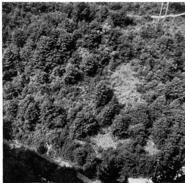
Abb. 8 und 9 Felssturz in Wattens (Unterinntal): Eine langsam abgleitende Quarzphyllit-scholle hatte ein darunterliegendes E-Werk zerstört und den Aufstau des Wattenbaches befürchten lassen. Deshalb wurde der Hang abgeböscht und begrünt. Oberes Bild während der Abböschungsarbeiten 1951, unteres Bild Zustand 1960, bei dem die künstlichen Begrünungsmaßnahmen überhaupt nicht mehr erkennbar sind. Vogelschaubild von einer gegenüberliegenden Felswand aufgenommen
