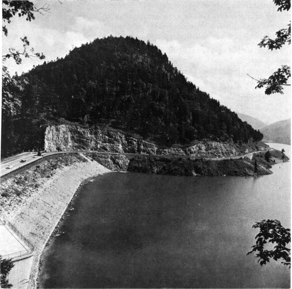
Abb. 5 Rückhaltespeicher mit Kraftwerk.
