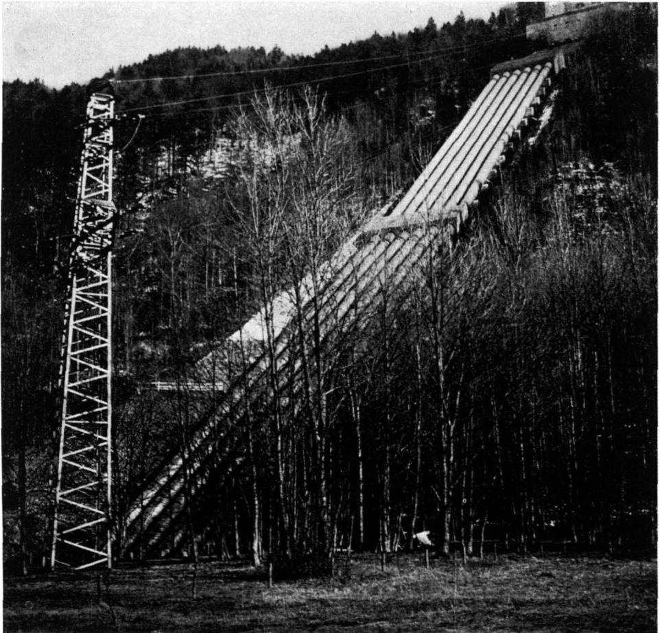
Abb. 2 Druckleitungen eines Hochdruckkraftwerkes.
