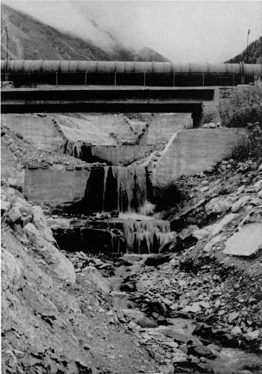
Abb. 5 Wasser aus Wildbächen wird in Druckrohrleitungen „gepreßt“. Auch diese verunzieren die Landschaft (Foto: J. Schenk)
