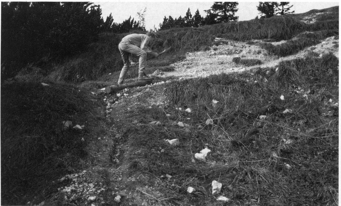
Abb. 7: Erosionsansatz unterhalb einer Wasserauskehre.
