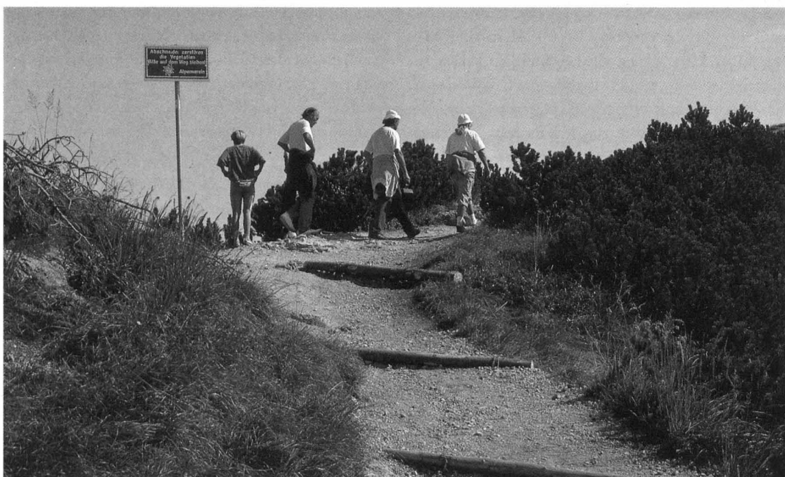
Abb. 2: Am Weg eingebaute Wasserauskehren aus rohen Nadelholzstangen.
