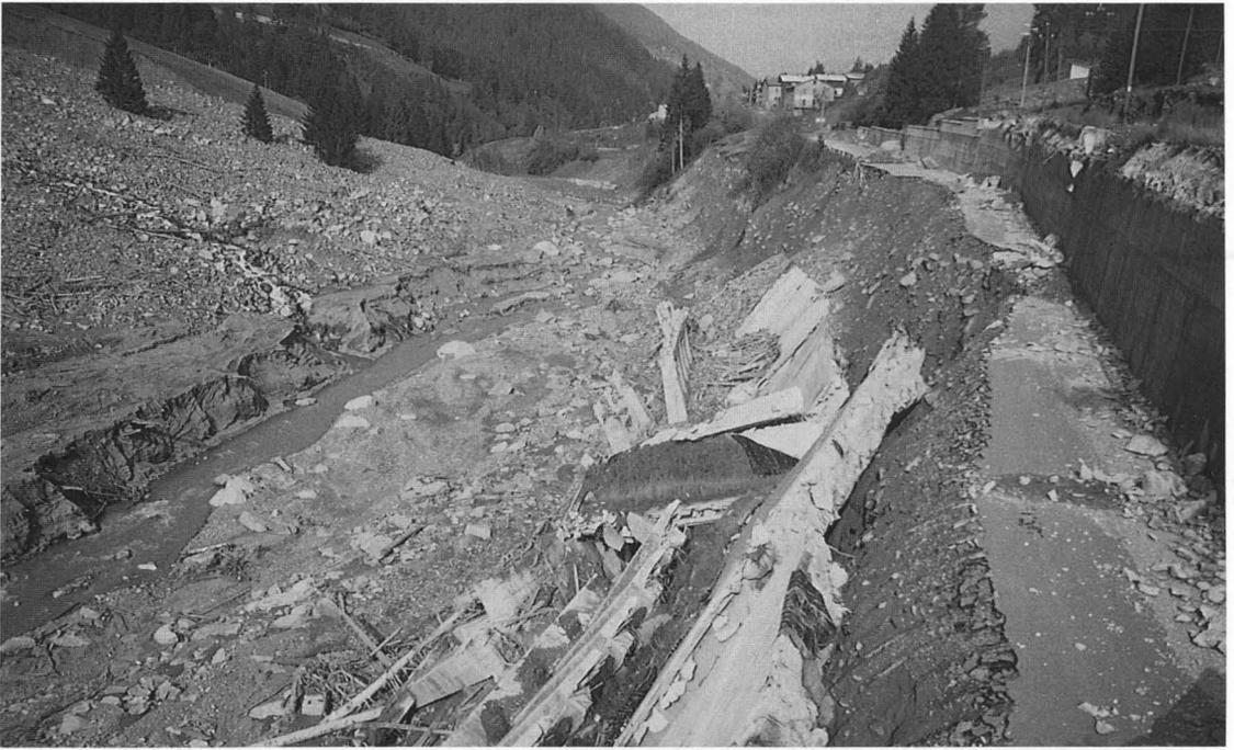
Abb. 16: Extreme Hochwasser mit starken Geschiebeeinstößen können zu schweren Schäden führen wie hier an der Straße nach Bormio.
