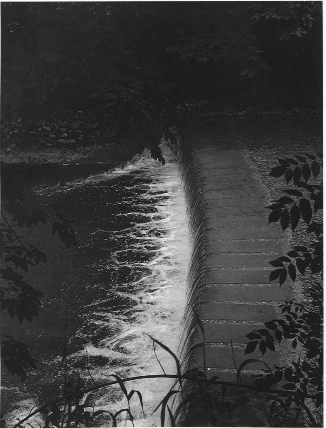
Abb. 27: In den im vorigen Jahrhundert zu Triftstrecken für Salinenholz ausgebauten Wildbächen wurde die Bachsohle mit niedrigen Schwellen aus Holz oder Stein stabilisiert.
