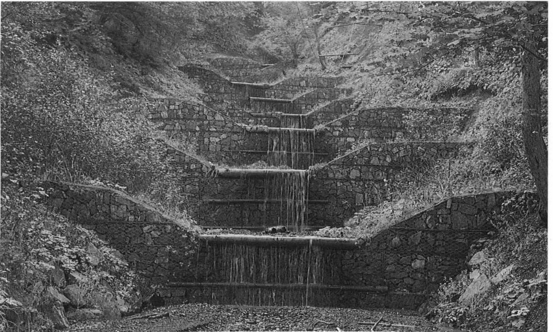
Abb. 19: Diese Sperrentreppe sichert die Bachsohle in einer Erosionsstrecke vor weiterer Eintiefung. Sie stützt zugleich die Hänge und mindert so übermäßigen Geschiebeanfall.
