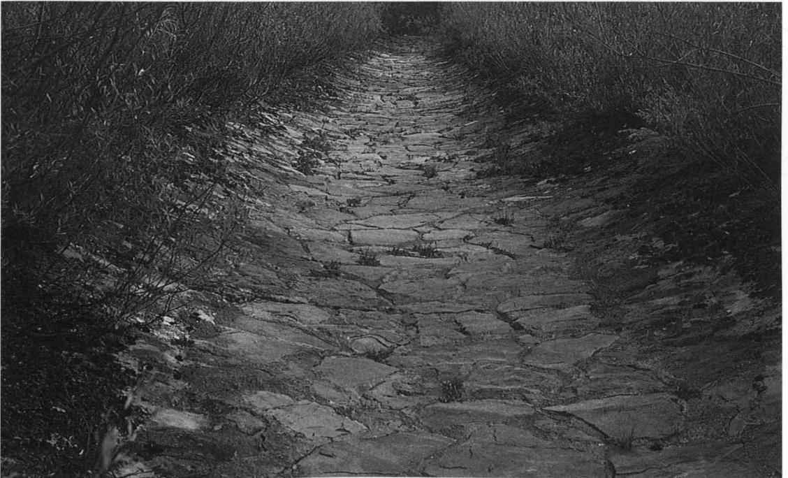
Abb. 21: Um das Ausbrechen von Wildbächen auf Schuttkegel zu verhindern, sorgen Stoßgerinne für den kontrollierten Abfluß von Hochwasser und Geschiebe.
