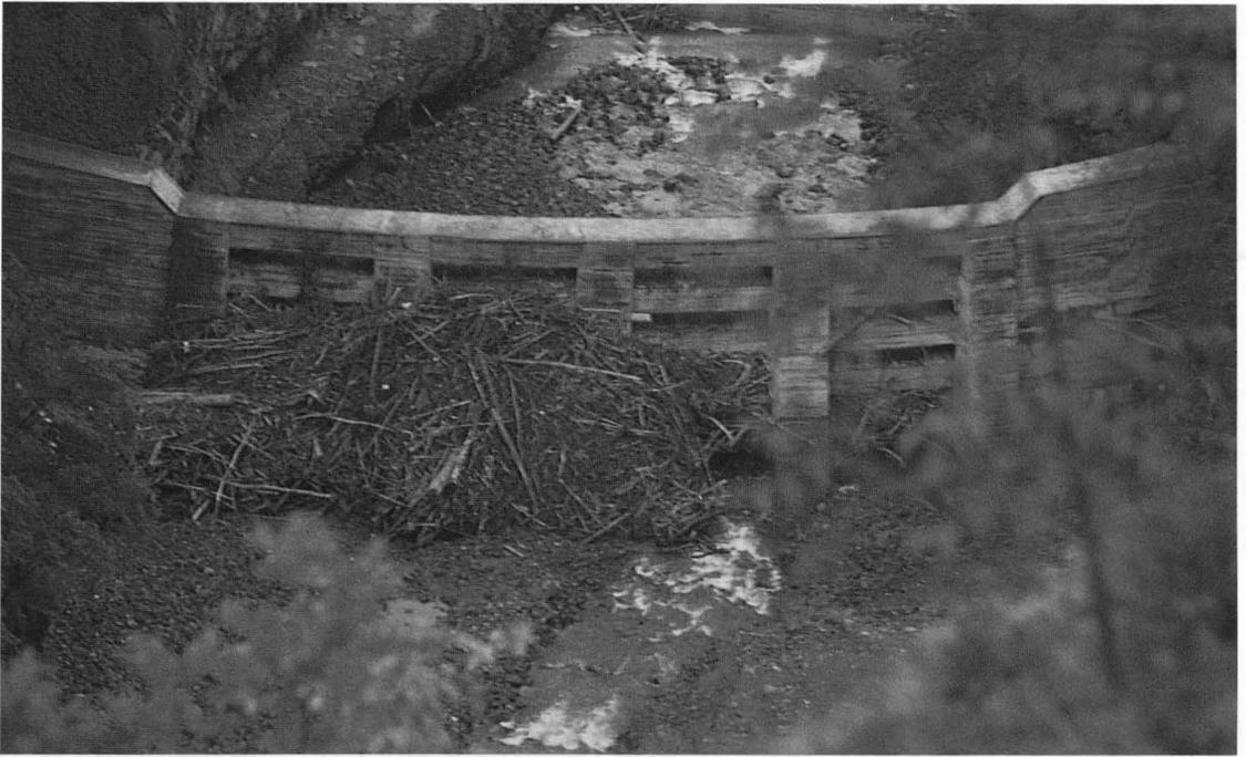
Abb. 20: Neben dem Geschiebe ist Wildholz eine besonders große Gefahr für menschliche Siedlungen und Verkehrswege. Speziell gebaute Sperren halten das Holz zurück.
