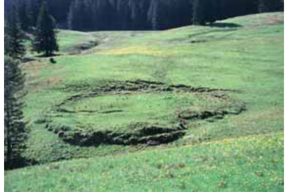
Bild 8: Erosionsschaden auf baulich veränderten Pistenabschnitten
