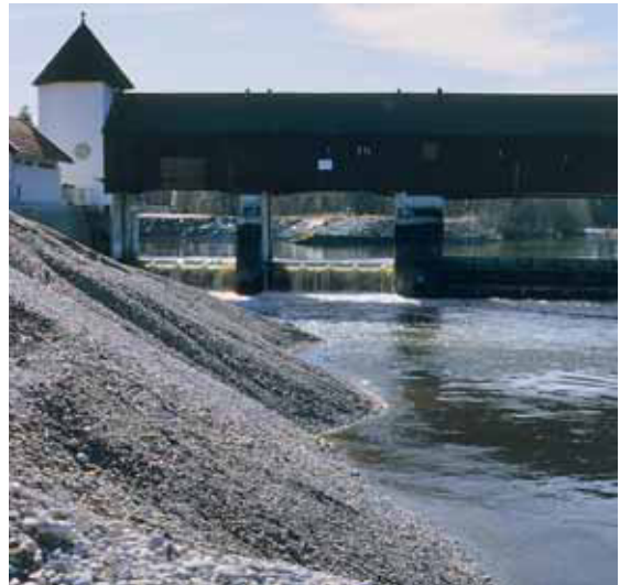
Abb. 5: Isar, Ausleitungwehr Mühlthal / Straßlach / Obb. ; das in den Kanal verfrachtete Geschiebe wird im Unterwasser der Wehranlage wieder in das Flussbett eingebracht.
