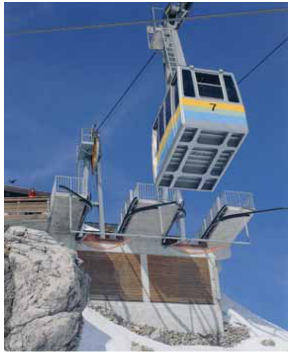
Bild 2: Kabinenbahn mit Bergstation
