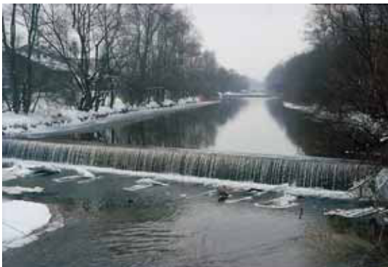
Abb. 3: Absturzbauwerk / an der Mangfall / Obb. im Unterlauf des ausgebauten Wildbachs beeinträchtigt die biologische Durchgängigkeit.
