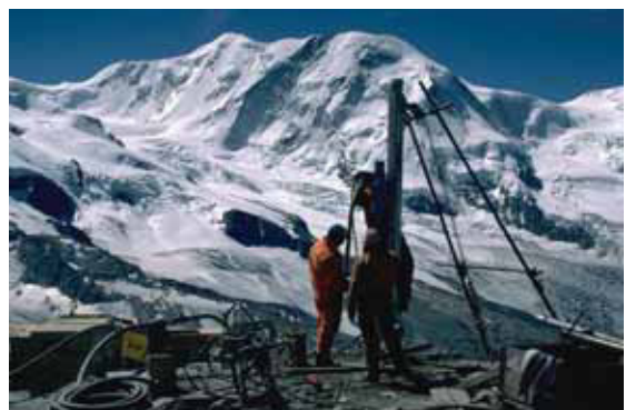
Abb. 6: Bohrung eines 100 m tiefen Bohrlochs nahe dem Stockhorn (CH, 3400 m ü. M.) oberhalb von Zermatt. Die Bohrung wurde 2000 im Rahmen des EU-Projekts PACE erstellt und seither werden darin kontinuierlich die Temperaturen des Untergrunds gemessen. Im Hintergrund sind der Grenzgletscher und der Lyskamm sichtbar.
