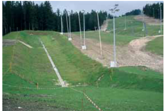
Bild 4: Flutlicht- und Beschneigungsanlage
