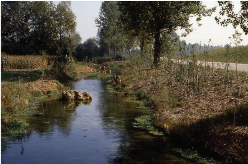
**Bild 14:** Isar, Stützkraftstufe Landau. Der zur Sicherung der Grundwasserstände außerhalb der Staustufe notwendige Vorfluter wurde als naturnaher Auebach gestaltet. (Foto: W. Binder).
