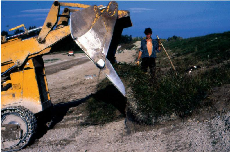
**Bild 16:** Aufbringen der abgeschälten Rasensoden auf den neuen Stauhaltungs-dämmen.
