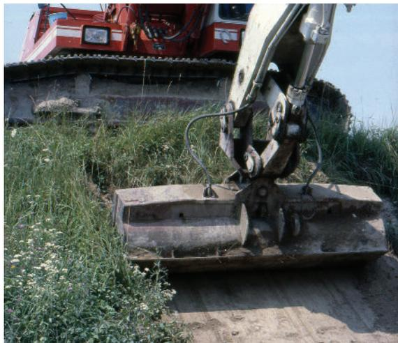
**Bild 15:** Isar, Stützkraftstufe Landau. Abschälen von Rasensoden von den alten Deichböschungen. (Foto: P. Jürging).
