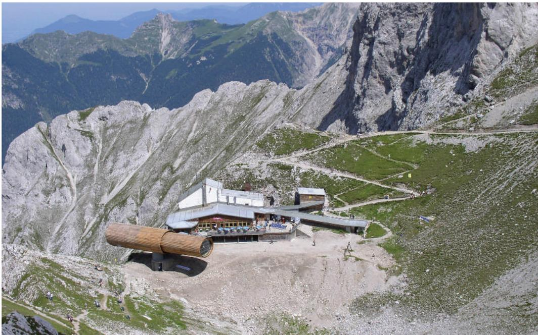
Abb. 2: Die 34-Meter-Fernrohr-Attrappe aus 1.200 Tonnen holzverkleidetem Beton ist sicherlich eine bautechnische Meisterleistung neben der Karwendel-Bergstation (Mittenwald) in 2244 m Höhe. Man beachte die Größe des Rohrs im Vergleich zur Bergstation und dem nicht gerade winzigen Gasthaus. Rechts unten die Westl. Karwendelgrube, alles im NSG "Karwendel und Karwendelvorgebirge" und NATURA 2000-Gebiet "Karwendel mit Isar". (Foto: R. Erlacher).
