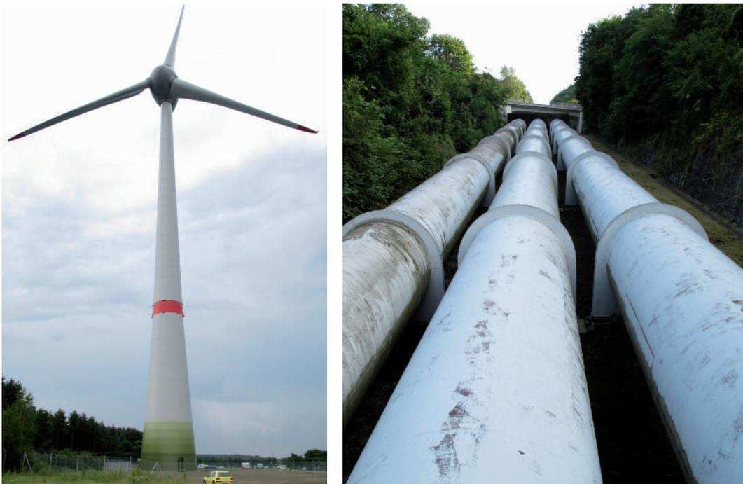
Abb. 6 und 7: Das weltgrößte Binnenwindrad am Standort in der Lausitz, Nabenhöhe 138 m, Rotordurchmesser 127 m, installierte Leistung 7,5 MW (links). Druckleitung eines Pumpspeicherwerkes (rechts). Regenerativen Energien gehört die Zukunft. Aber nicht um jeden Preis. Der Mensch ist auch Ästhet, also darf die Schönheit der Landschaft nicht blindlings geopfert werden. (Foto: H. Röhle).
