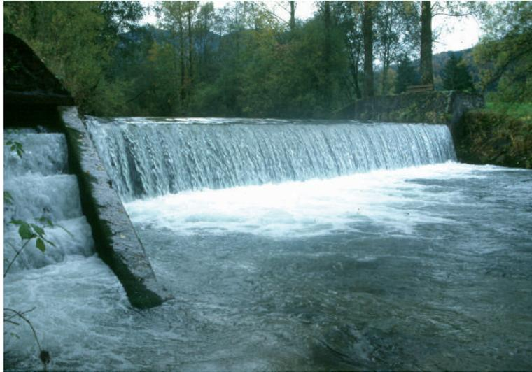
Abb. 8a und 8b: Naturnaher Wasserbau am Beispiel des Wildbaches Leitzach/Gemeinde Fischbachau/Obb. bei Mühlkreit vor und nach der Maßnahme. Die unpassierbare Wehranlage wurde in eine naturnahe Sohlgleite umgebaut zur Verbesserung der Durchgängigkeit und des Angebots an Lebensräumen im Gewässer; Planung und Bauausführung durch das Wasserwirtschaftsamt Rosenheim, Flussmeisterstelle Miesbach. Im Hintergrund Jägerkamp und Benzing/Mangfallgebirge.
