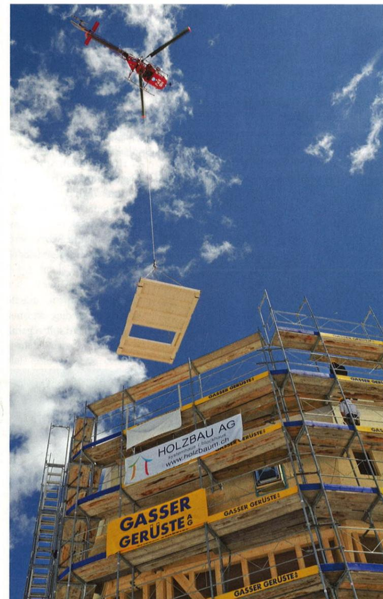
Um die Hütte zu erstellen, waren allein für die gut 400 Fertigholzelemente 400 Hubschrauberflüge von der Gornergratbahnstation «Riffelboden» aus nötig. Die Elemente hatten ein Gewicht von bis zu 2200 Kilogramm bei einer Länge von maximal sieben Metern.
