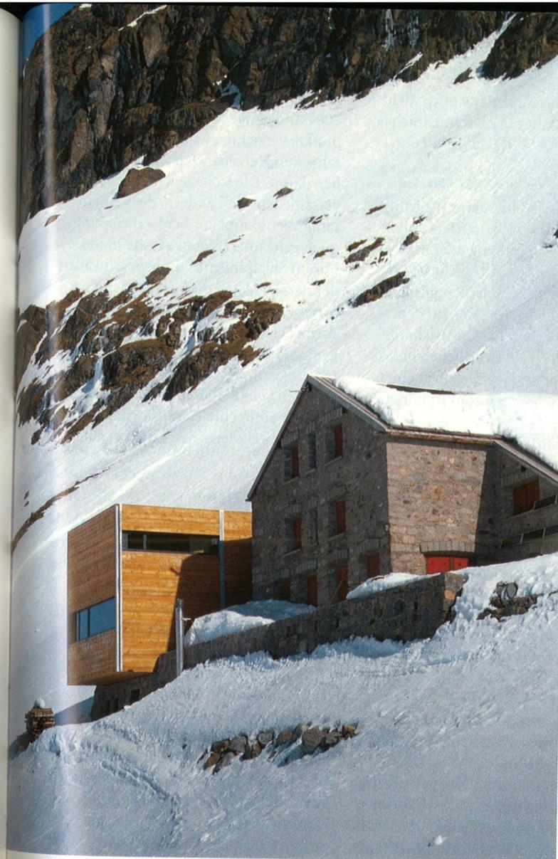
Alt und Neu werden in Formgebung und Materialisierung deutlich getrennt: Der Altbau wurde mit Natursteinen aus der Umgebung gebaut, der Neubau mit einem Kleid aus massiven Lärchenbohlen versehen, eingespannt zwischen verzinkten Stahlträgern.
