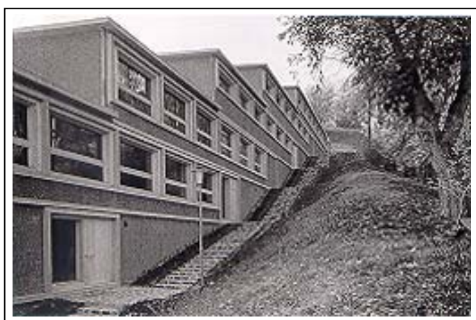
Abbildung 6: Schulgebäude, Mastrils / CH; Arch.: Andreas Hagmann & Dieter Jüngling (Foto: © Hagmann & Jüngling)
