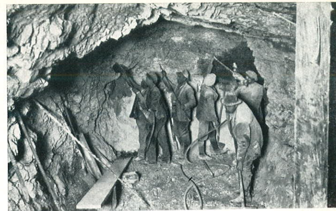
Tunnelarbeit mit Preßluft-Bohrern.
