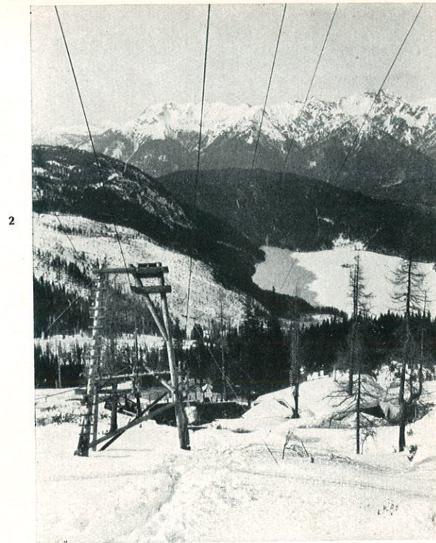
Riffelriß mit Seilbahn. (1) Der eisbedeckte Eibsee, (2) die Törlen, deren südlicher Teil waldfrei ist infolge Windbruchs. Im Hintergrund die Ammergauer Alpen, darunter der Hohe Seeberg. Daposcheg phot.
