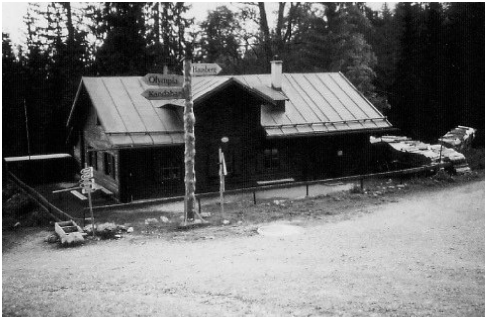
Bild links: Die Tröglhütte
