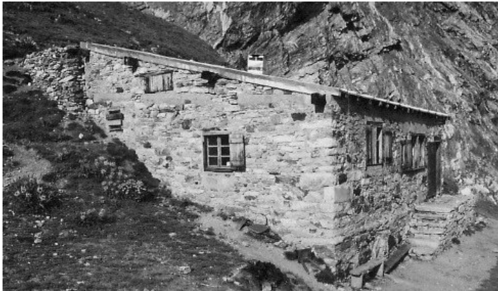
Bild links: Die alte Aosta-Hütte (inzwischen ersetzt durch einen Neubau)
