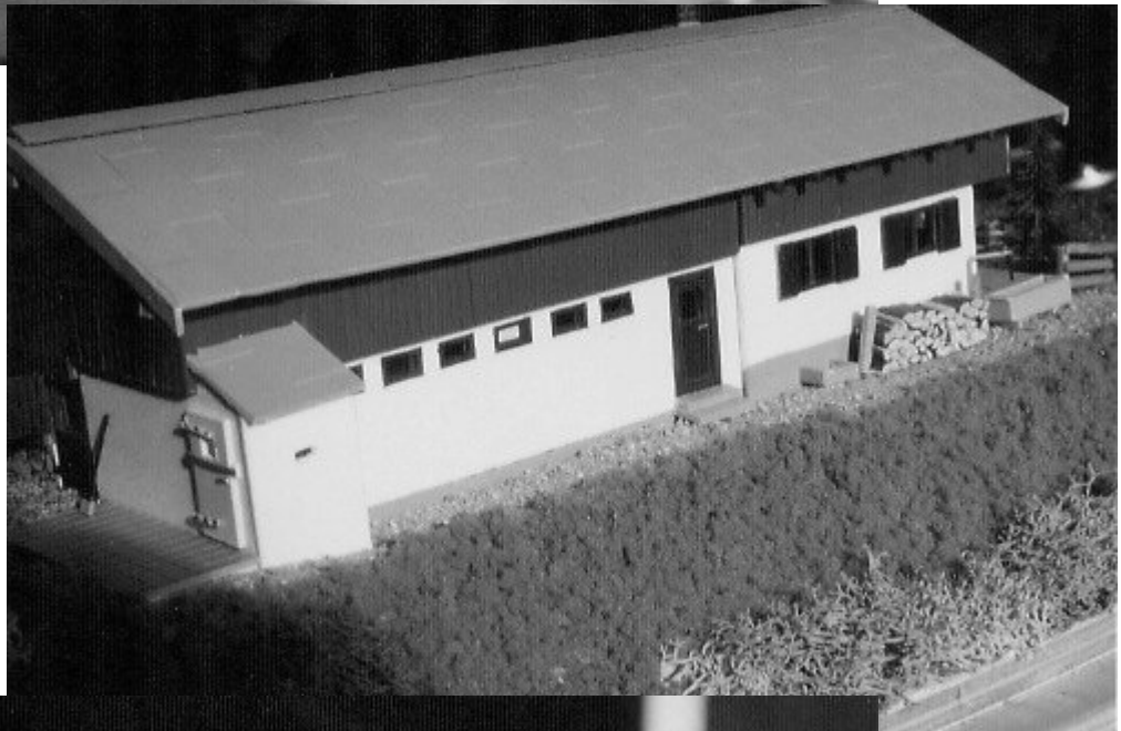
Bild rechts: Die Nordostseite eines der fertigen Modelle mit dem Toilettenanbau
