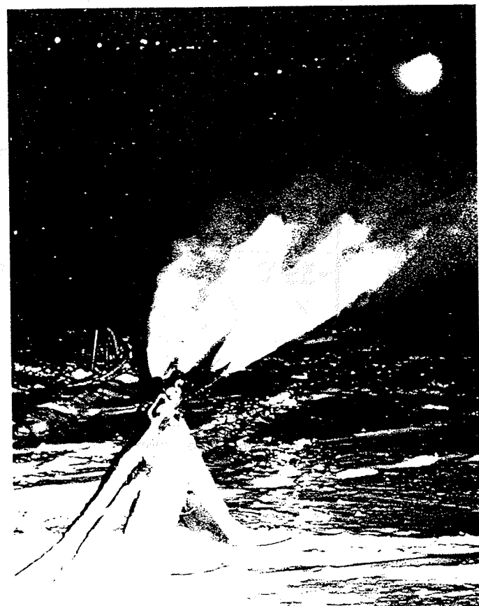
Vierstrahlige Druckluftkanone der Beschneigungsanlage Savognin
