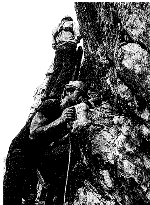
Über die Furcia Rossa Spitzen stellte ein hochalpiner öst.ung. Frontklettersteig die Verbindung zwischen dem M. Castello und dem M. Vallon Bianco her. Unter Einsatz modernster Befestigungstechnik wurden nun die neuen Sicherungsseile im Fels der südlichsten Spitze, 2806 m, verankert.
