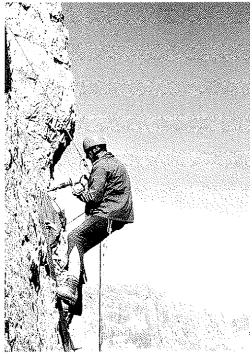
Setzen der Bohrlöcher für die Gewindeisen
