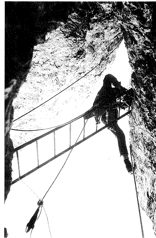
Querung im Felskamin, bei Baubeginn alpiner Schwierigkeitsgrad 4+
