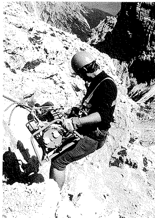
Setzen der Bohrlöcher für die Gewindeisen
