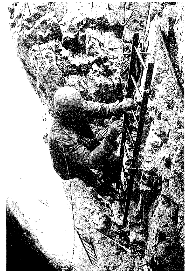
Montage einer Eisenleiter
