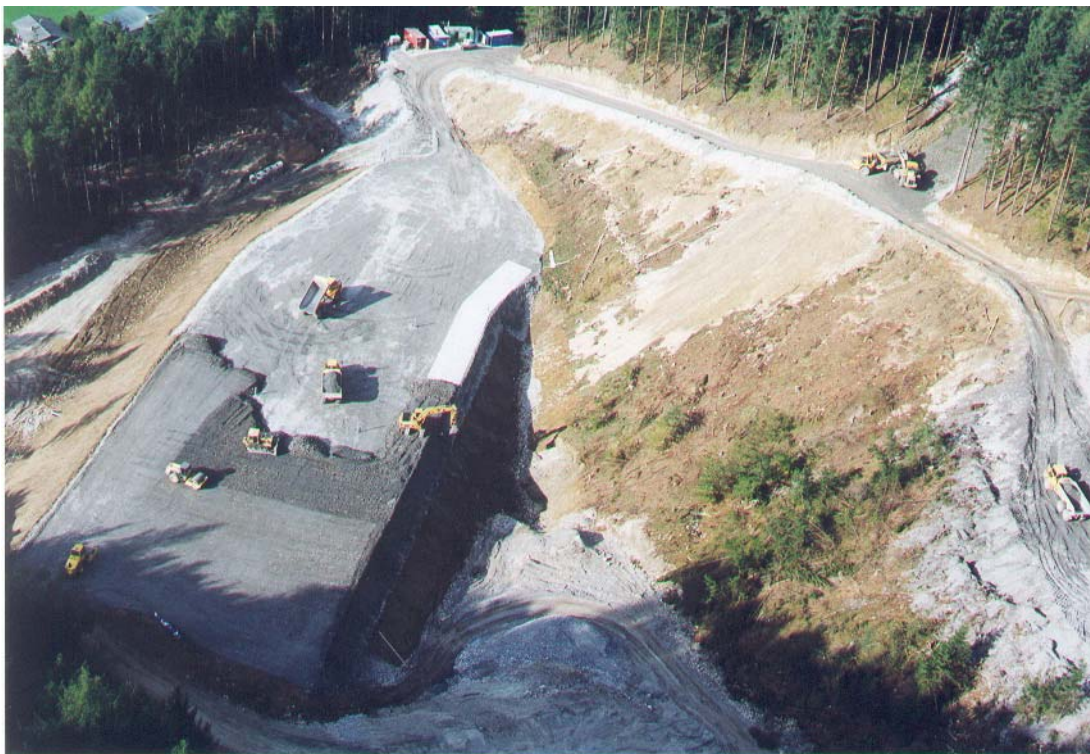
Abb. 4 und 5 Lagenweise Schüttung und Verdichtung der Dämme Fig. 4 and 5 Filling and compaction in layers
