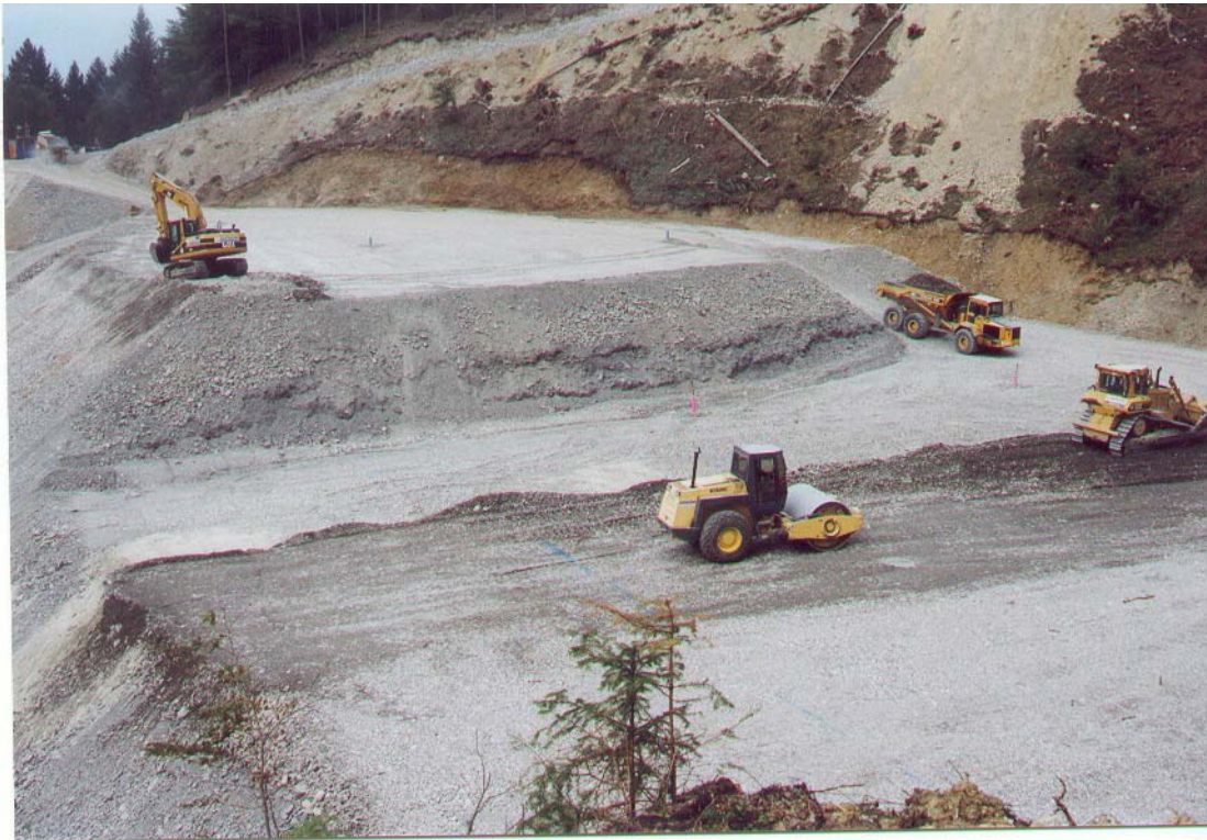
Abb. 4 und 5 Lagenweise Schüttung und Verdichtung der Dämme Fig. 4 and 5 Filling and compaction in layers
