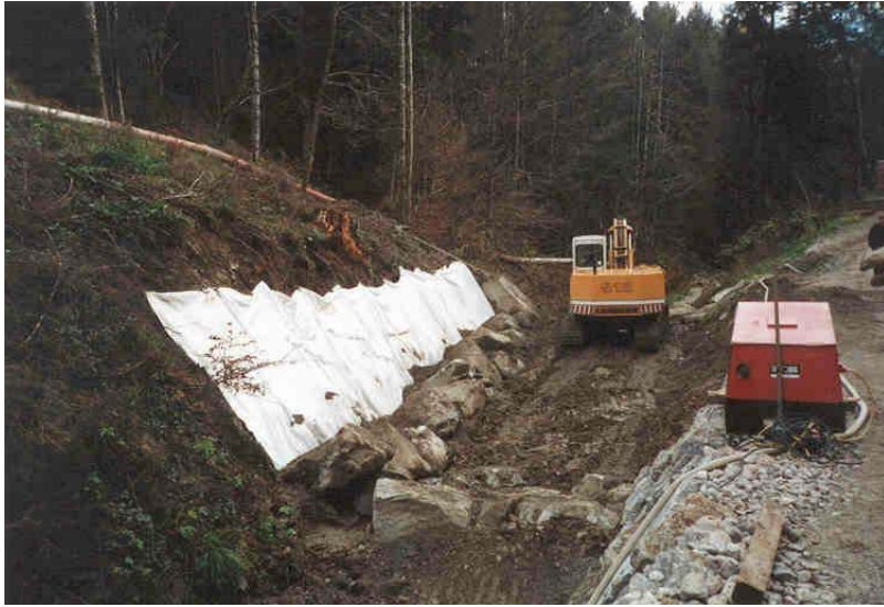
Abb.4: Deckwerk mit Bauvlies und Sohlrampe im Seeton Fig.4: Construction of the revetment in clay
