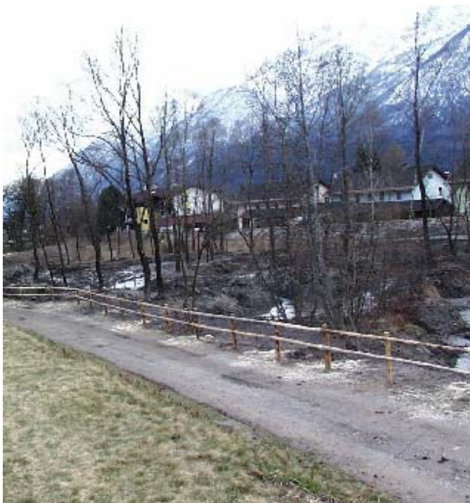
Abb. 4: Feingeschiebeabsetzbecken nach schutztechnisch und ökologisch orientierter Gewässerpflege
