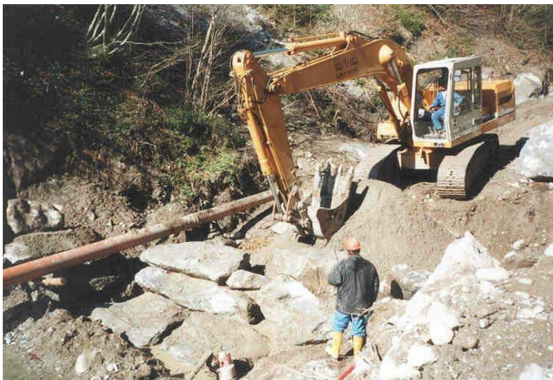
Abb.3: Sohlrampe in Bau
