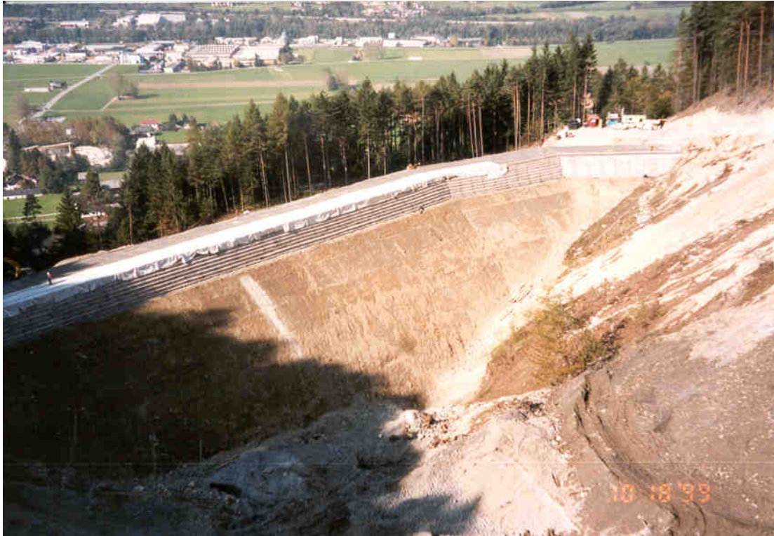
Abb. 7 Fertiggestellter Steinschlagschutzdamm Fig. 7 Completed rockfall protection dam
