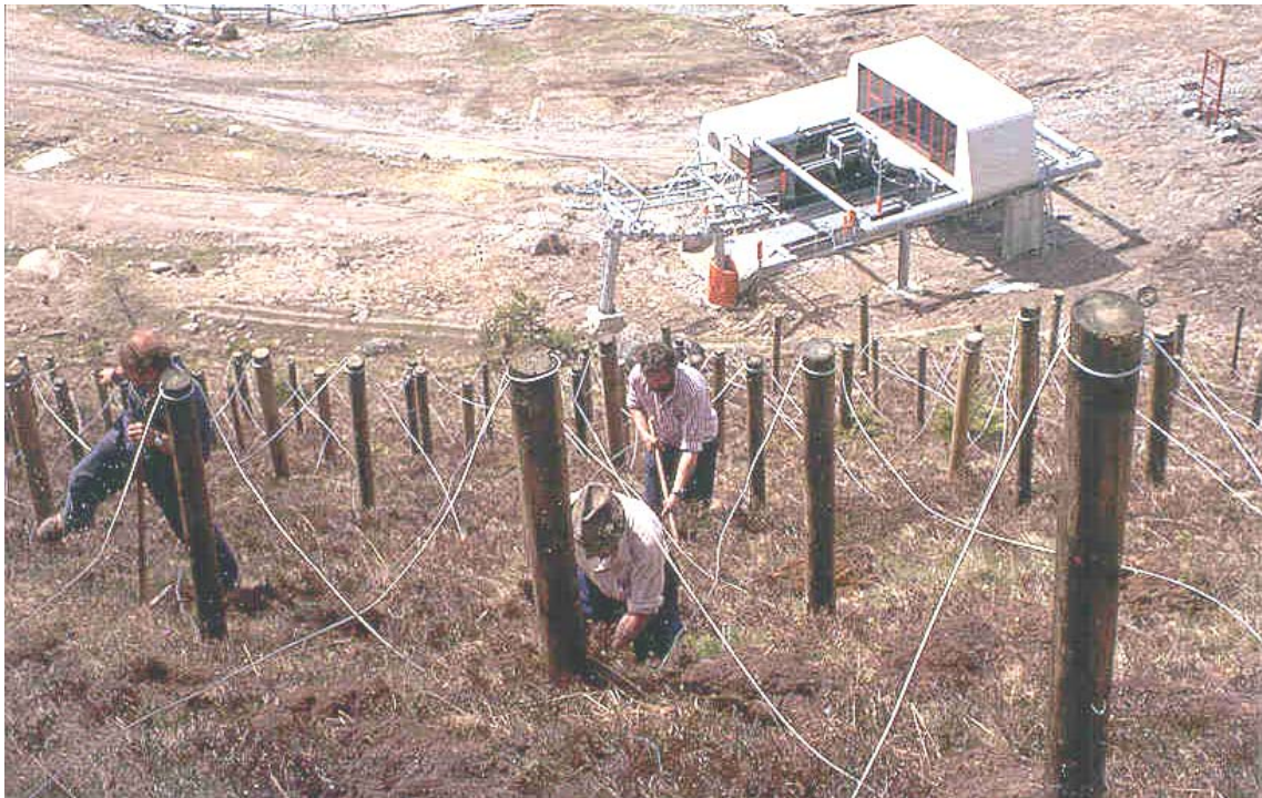
Abb.8: Mit Draht verspannte Verpfählung als Gleitschneeschutz.
