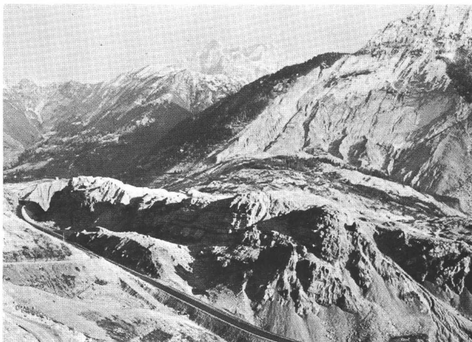
*Bild 44. Blick von NW auf die Felsgleitung von Vaiont (76.03). Gut zu erkennen ist die Abgleitfläche am Monte Toc (rechts hinten) und die größtenteils im Verband gebliebene Gleitscholle (jenseits der Straße).*
