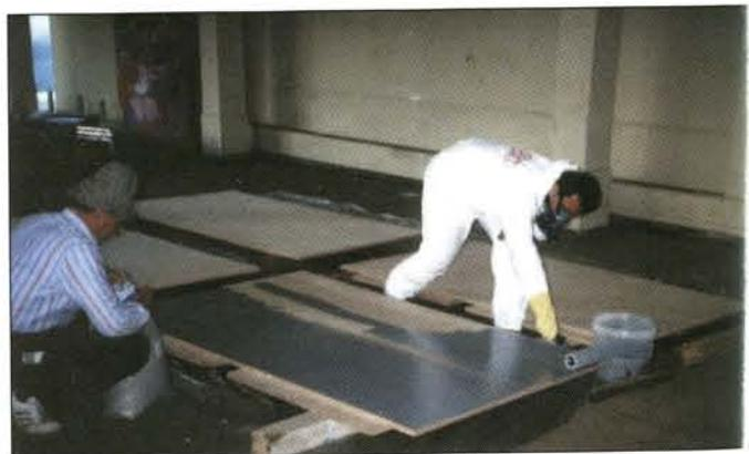
wichtigen Sicherungspunkte mussten im Mauerwerk verankert werden. Multiplex-Mehrschichtplatten wurden eingepasst und mit Bohrungen und Einschlagmuttern für die Klettergriffe versehen. Dann wurden sie mit einer Zweikomponenten-Kunstharzbeschichtung überzogen und mit Quarzsand abgestreut, um die Griffigkeit der Platten zu erhöhen. Ein hohes Gerüst war erforderlich, um die Unterkonstruktion auch an der Decke anzubringen und die Platten zu befestigen.
