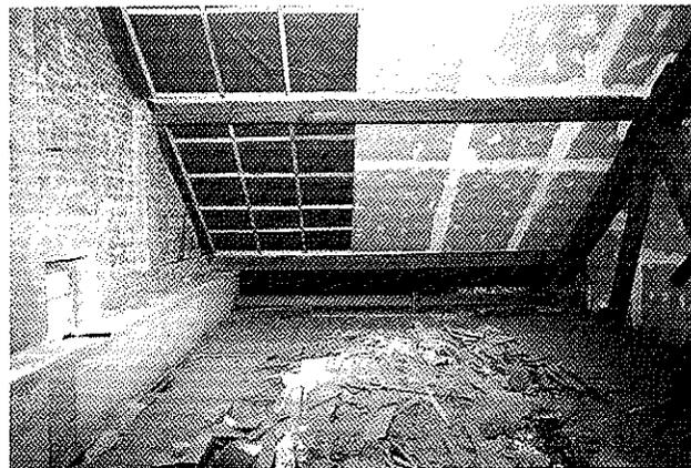
Dachboden mit Ringanker an der Giebelseite und Verschalung des Dachstuhls. Der später entfernte Dachboden ist noch vorhanden.
