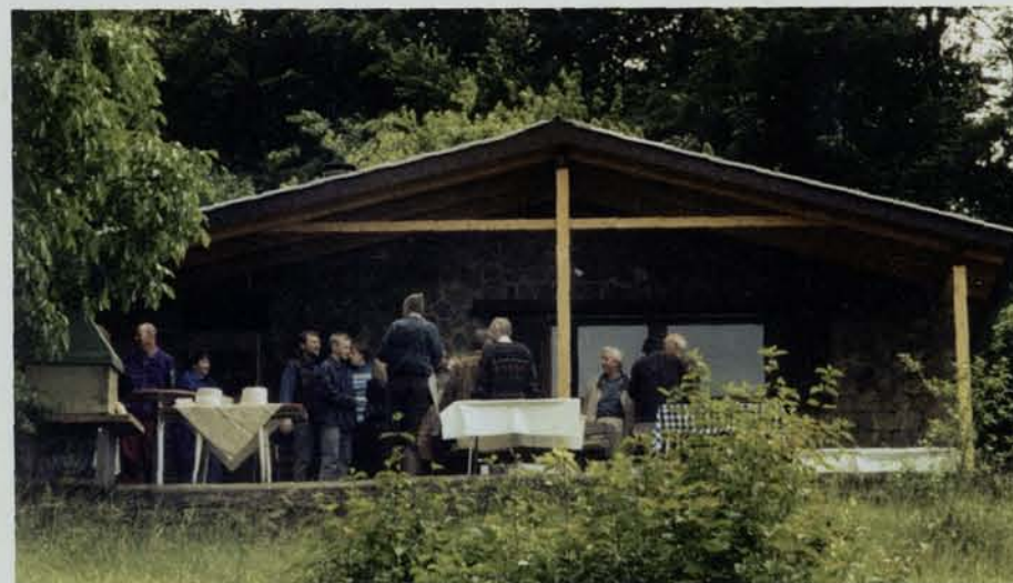
Die Kansteinhütte nach der Erweiterung
