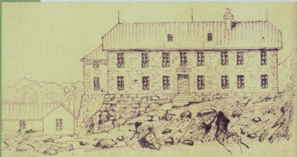
Das neue Hannoverhaus sollte ursprünglich unmittelbar oberhalb der alten Hannoverhütte errichtet werden, die alte Hütte sollte künftig nur noch als Führerlager genutzt werden.
