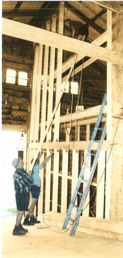
wir durch den Test führen – jeden Haken mit 800 Kilogramm belasten und das Ergebnis dokumentieren. Da substantielle bauliche Veränderungen vorgenommen wurden, musste ein Bauplan eingereicht werden.
