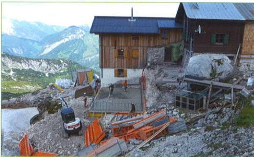
Mit dem Hubschrauber wurde der Beton für die Grundsole zur Baustelle geflogen ...
