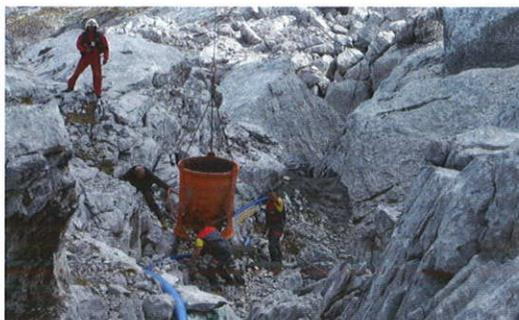
Die 1,4 Kilometer lange Wasserleitung musste im Felsboden einbetoniert werden.
