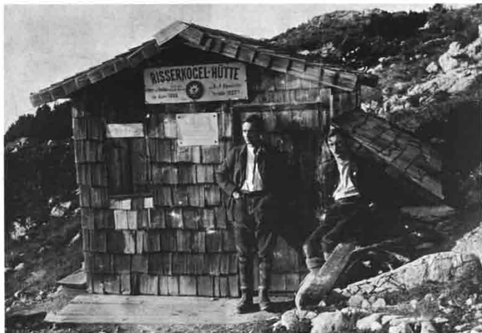
Risserkogelhütte 1888–1953 (Hufeld/Knott) (Foto Archiv 1925)
