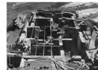
Alles was übrigblieb: Die Grundmauern
