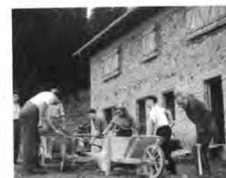
Eigenleistung beim Neubau
