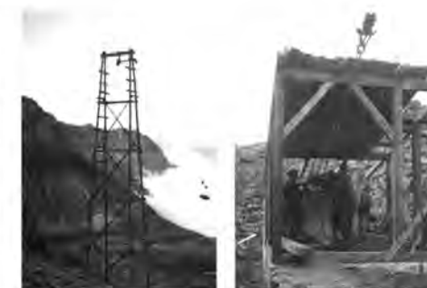
... und Stück für Stück mit einer eigens gebauten provisorischen Seilbahn auf den Berg transportiert
