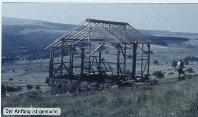
Steinesuchen für das Fundament
