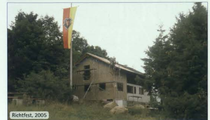
Der Richtbaum wird aufgestellt
